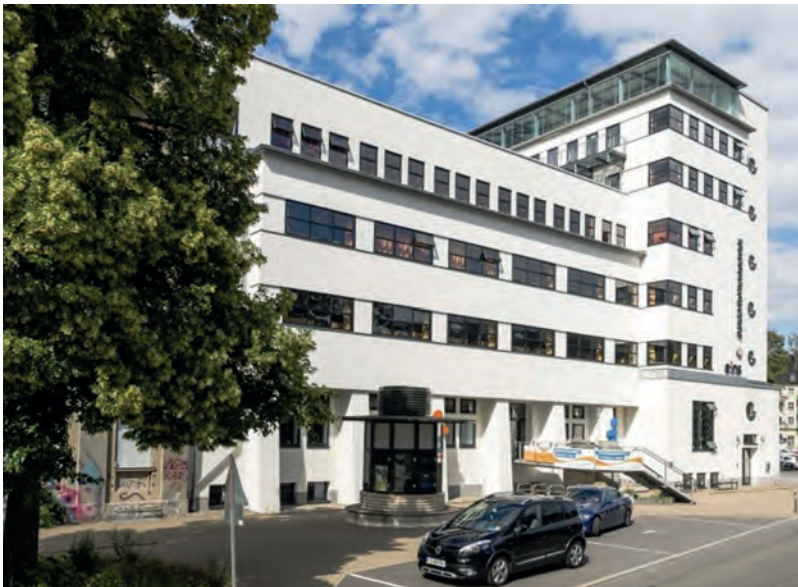
Abb. 9: Umspanwerk am Getreidemarkt – heute Jugendherberge, Foto: Landesamt für Denkmalpflege
