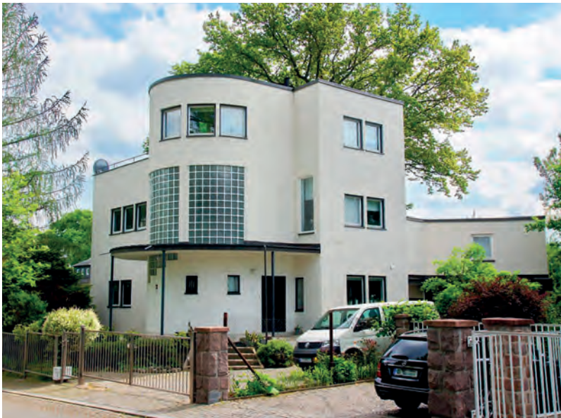
Abb. 6: Haus Feistel Kesselgarten 3, Archiv Denkmalschutzbehörde Chemnitz
