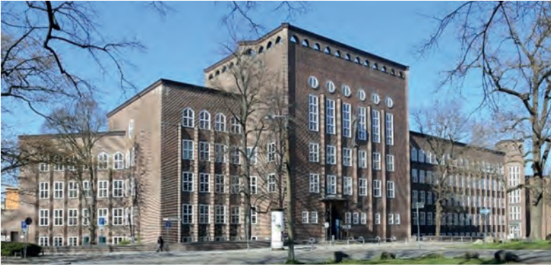
Abb. 4: Industrieschule am Park der Opfer des Faschismus (OdF) 2020, Archiv Denkmalschutzbehörde Chemnitz
