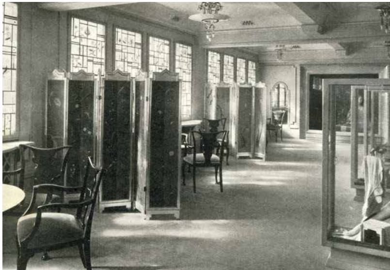
Abb. 1.1.1 „ALROWA“. Deutsche Strickerei AG in Chemnitz | Vorführraum
